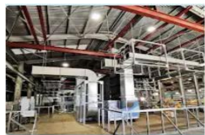
Fabrication & DFMA Centre.
